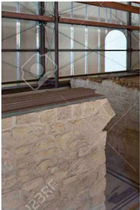
REFORÇOS METÁLICOS EM AUMENTO PAREDE ESTRUTURAL
