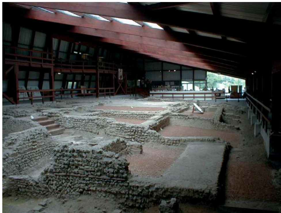
FIGURA 4.5: Vila romana de Lullingstone (1960-1963). O telhado destinado a proteger as paredes e mosaicos romanos é sustentado por grandes vigas monolíticas de madeira laminada. Estão inclinadas a criar uma galeria elevada para a visita. O edifício está completamente fechado para o exterior. Imagem brutalista da época. A imagem icônica do conjunto é o mosaico do Rapto de Europa.
