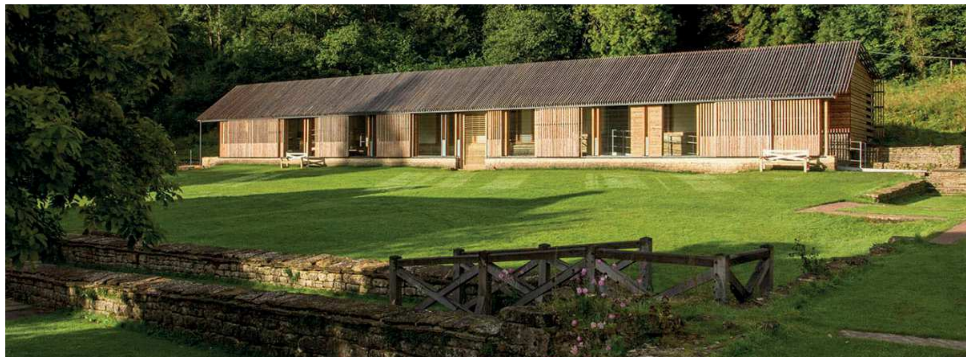
FIGURA 4.4: Villa de Chedwoth (Gloucestershire, Inglaterra). Na primeira intervenção (acima), um dos blocos da villa romana (paredes e teto) foi reconstruído com materiais tradicionais (madeira e alvenaria) para proteger os mosaicos. As novas intervenções na década de 90 do século XX foram realizadas em uma linguagem moderna (sempre com estrutura de madeira), embora continuassem aproveitando as paredes romanas.
