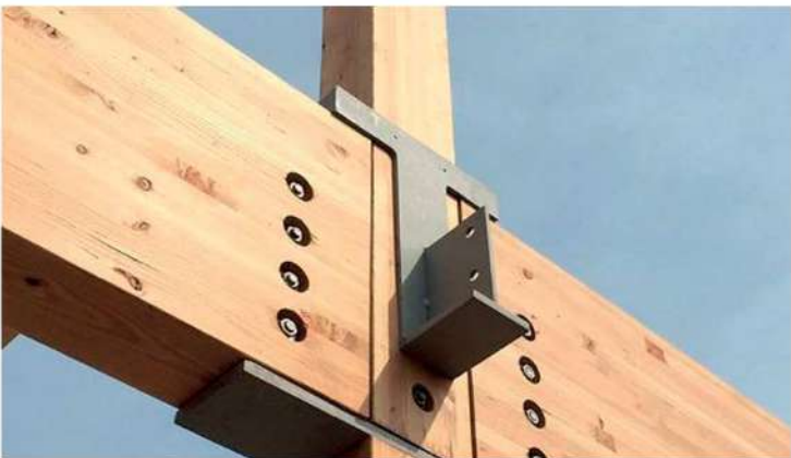
VIGAS PRINCIPAIS EM MADEIRA COM ALMA METÁLICA IMPLUVIUM ATRIO DOMUS
